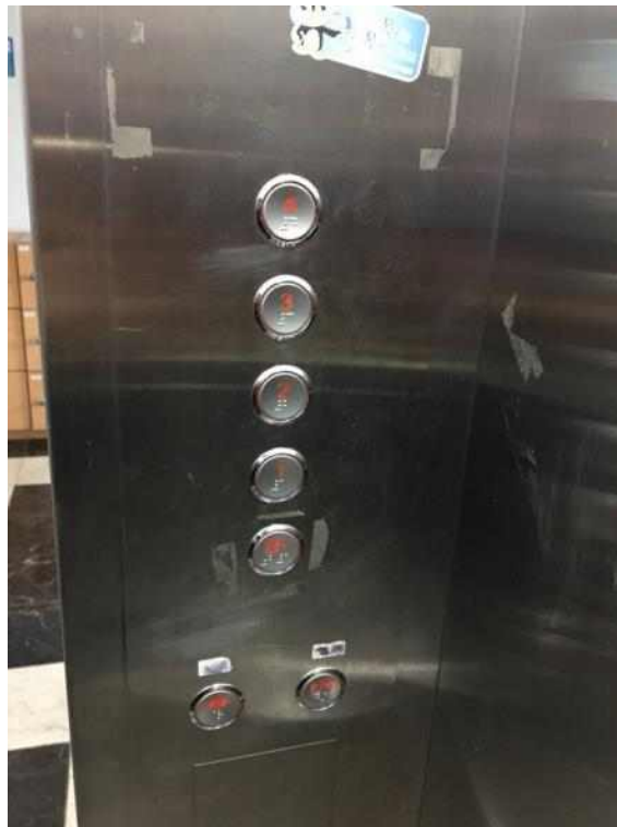
<그림 5-2> 자치센터의 점자 규격 중 자간 거리 부적정 사례
