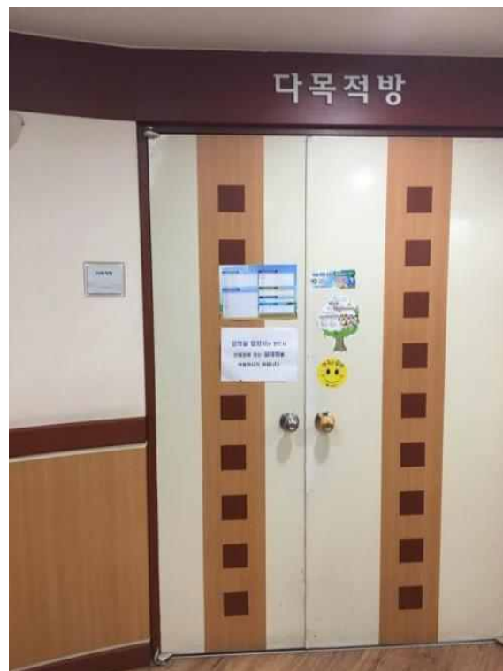
〈그림 5-1〉 자치센터의 점자 표지판 설치 위치 부적정 사례
