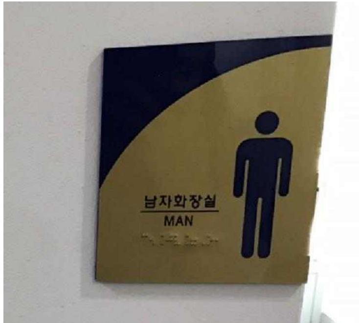
<그림 5-6> 우체국의 점자 규격 중 점 간 거리 부적정 사례
