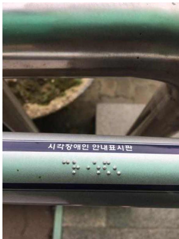
<그림 5-12> 보험공단의 점자규격의 점 간, 자간 거리 부적정 사례
