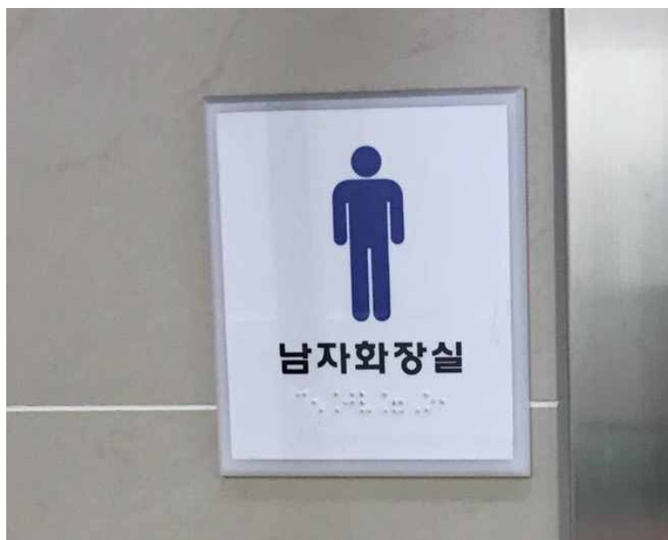
<그림 5-4> 보건소의 점자 규격 중 자간 거리 부적정 사례
